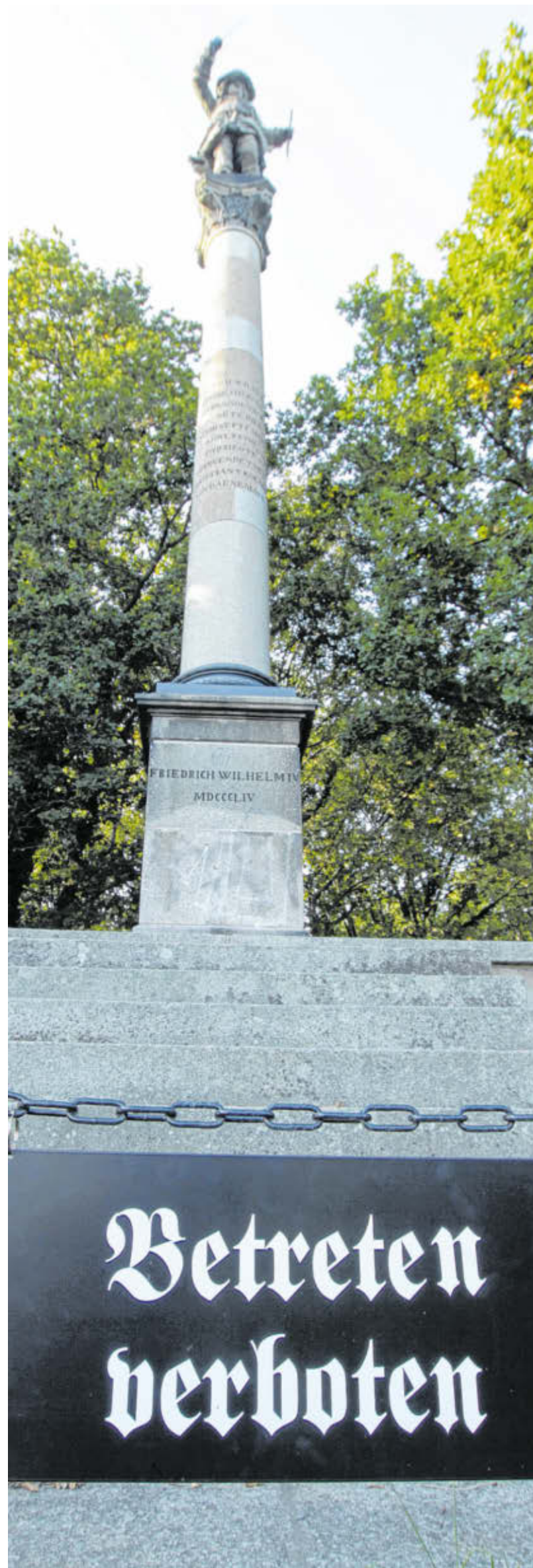
Während der Restaurierungsarbeiten hatte der Landkreis die sogenannte Preußensäule in Neukamp absperren lassen.
